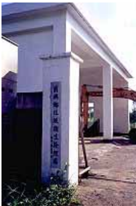
蘭嶼鄉垃圾衛生掩埋場
